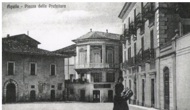
Figura 4. Foto storica raffigurante la testata dell'aggregato: è possibile notare come una delle unità abbia subito una sopraelevazione di un piano in epoca relativamente recente.
