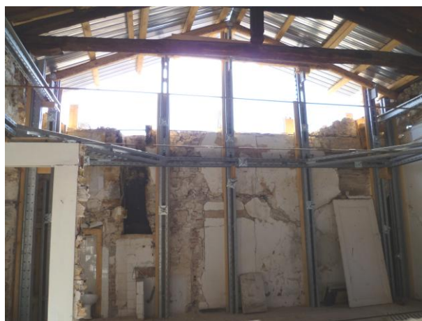
Figura 11. Realizzazione di interventi non appropriati: a) inserimento di cordolo in c.a.; b) apertura indiscriminata di nicchie, porte e canna fumaria.
