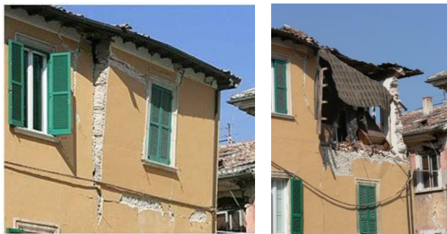
Figura 9. Ribaltamento della facciata prospiciente Piazza della Prefettura (Unità 5a).
