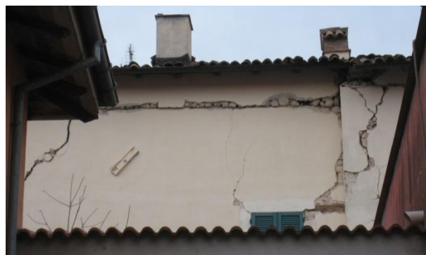
Figura 9. Ribaltamento della facciata prospiciente Piazza della Prefettura (Unità 5a).
