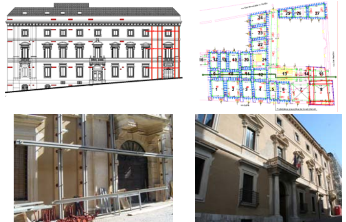
Figura 19 – Palazzo Quinzi a L'Aquila : intervento di ritegno della facciata con collegamenti di piano semidefinitivi e reticolo di profili in acciaio (lato destro)
