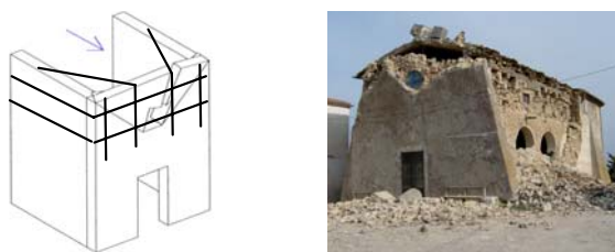
Figura 21 Ribaltamento del timpano: rotazione fuori piano a seguito di formazione di cerniere cilindriche con assi obliqui
