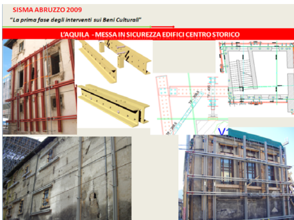
Figura 17. – cerchiaggio di edifici nel centro storico di L'Aquila con profili in acciaio e tiranti in funi o barre in acciaio
