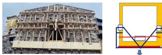
Figura 11. - Teatro S. Filippo (L'Aquila): cerchiaggio della facciata
