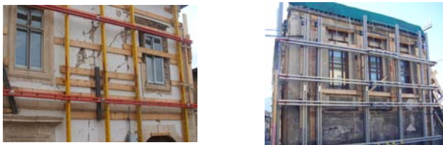
Figura 25 puntellatura di ritegno di facciata con profili e funi in acciaio
