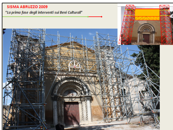
Figura 9 - Chiesa di S. Francesco di Paola: puntellatura della facciata con schema misto e cerchiaggio con funi
