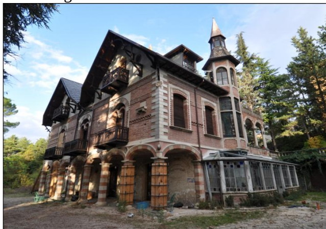
Figura 11. Vista della villa “La Silvestrella” a seguito delle opere provvisorie di messa in sicurezza conseguenti al sisma del 6 aprile 2009
