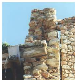
Fig A3.9 - Cellula di saturazione del tessuto edilizio (caso C, sopra) e conseguente assenza di ammorsamenti con i setti laterali (foto sotto)
