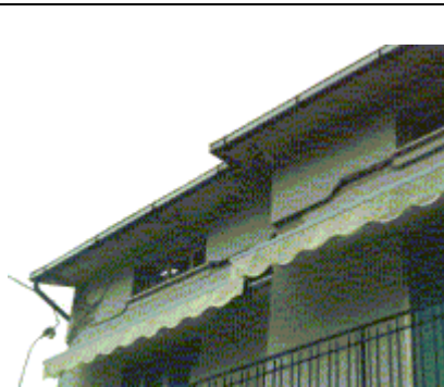
Fig. A4.18 - Grave dislocazione a livello del cordolo di sottotetto per spinta della copertura in c.a. (tipo 12); la lesione si presenta simmetricamente sulla parete esterna parallela opposta; lesione angolare (tipo 9). Livello del danno: D4-D5 (Busche, PG, 1998)
